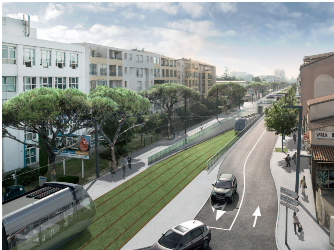
Le boulevard Déodat de Séverac avec la trémie sous les voies SNCF
